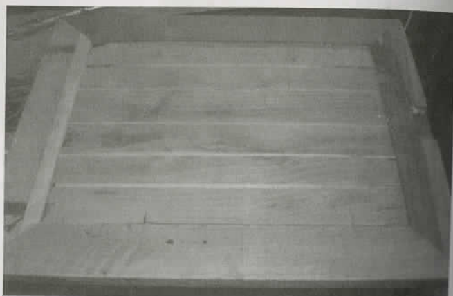
Un pannello montato grezzo dove si evidenziano i restauri effettuati sul telaio base
