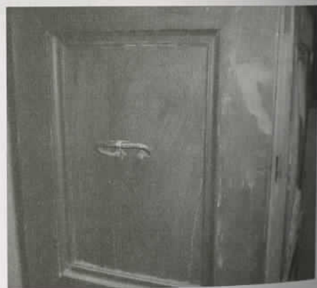
Immagini dei cassettoni smontati con, in evidenza, le maniglie per il trasporto
