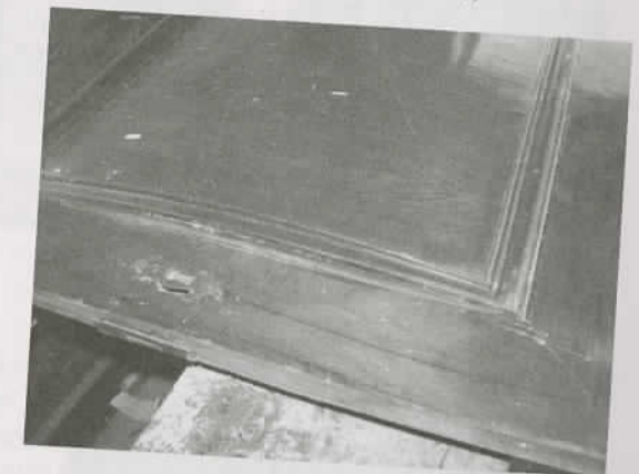
Alcune immagini degli sportelli smontati, in cui si nota la curvatura del legno (imbarcamento)
